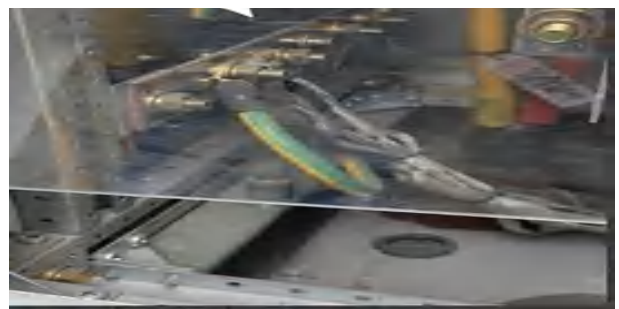
箱变低压侧电缆地线一点多线
