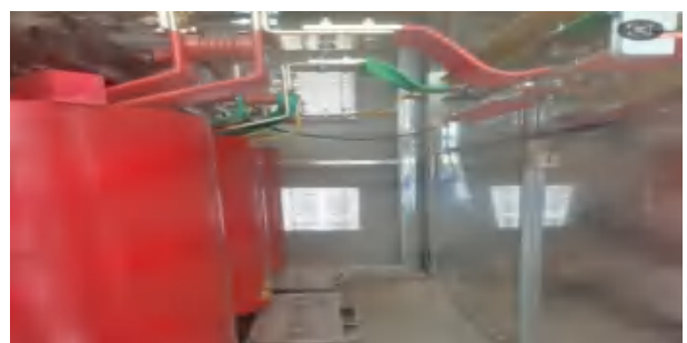
箱变低压侧电缆地线一点多线
